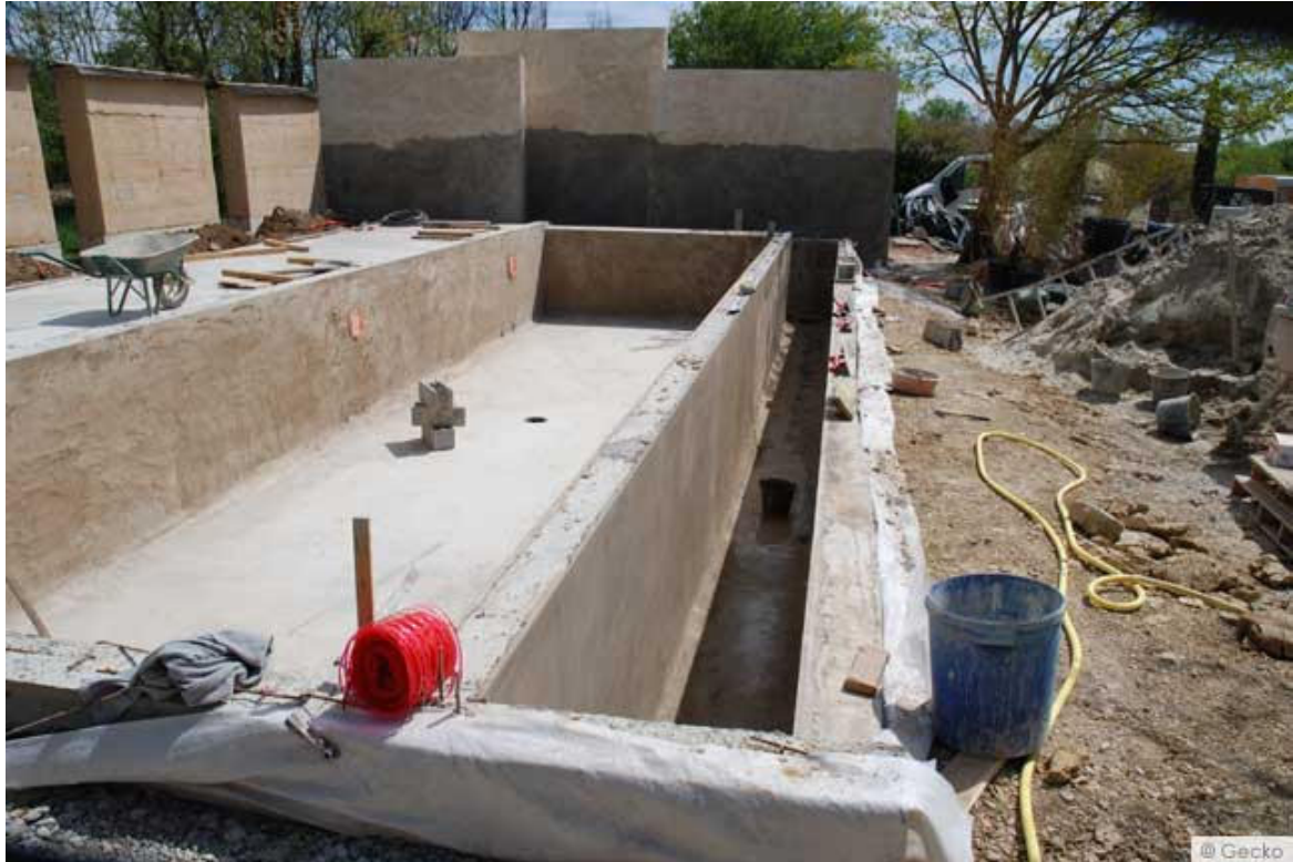
Le bac tampon , de la hauteur de la baignade, a été dissimulé par des poutrelles en béton sous le gravier .
