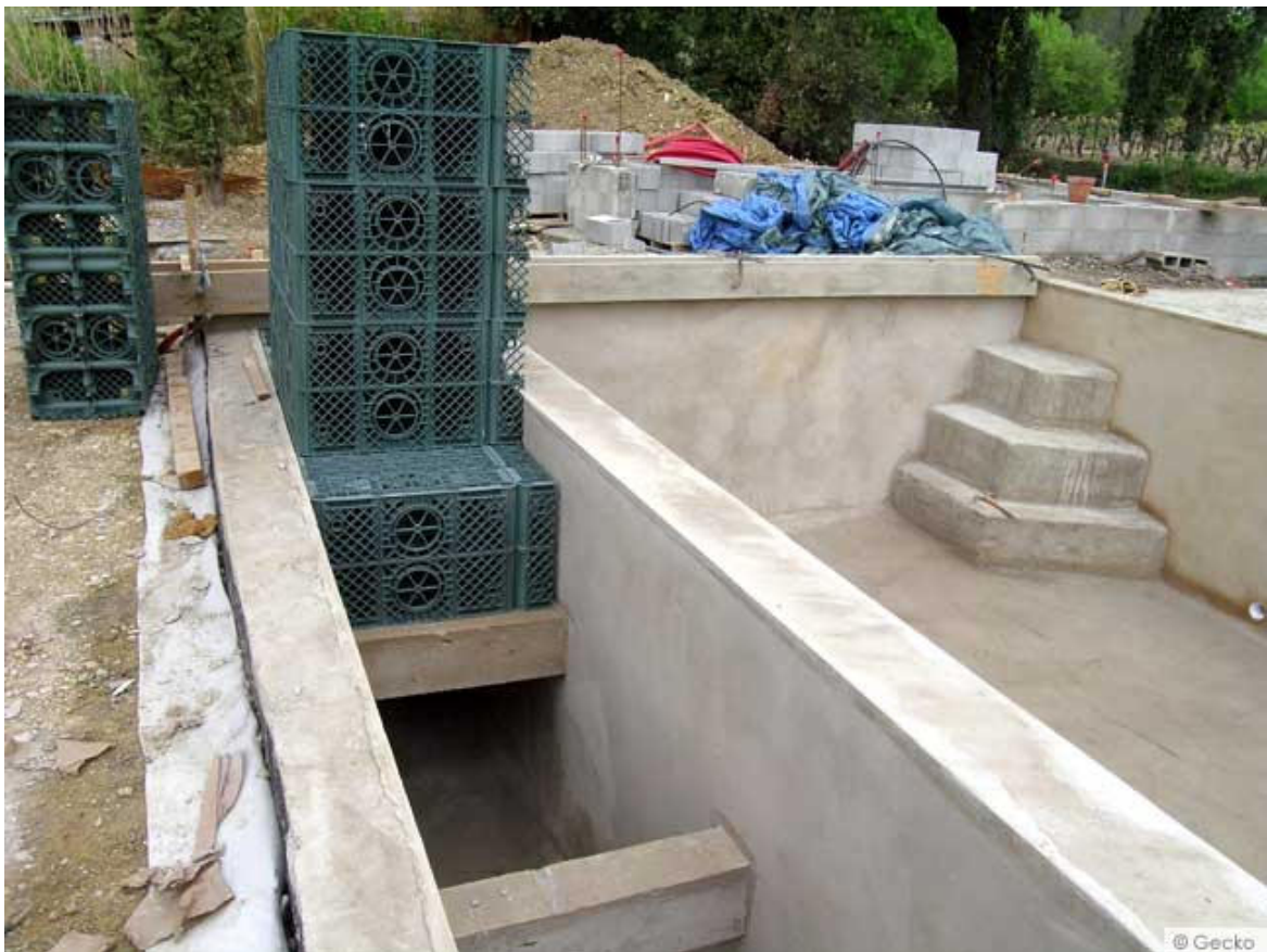
Le bac tampon , de la hauteur de la baignade, a été dissimulé par des poutrelles en béton sous le gravier .
